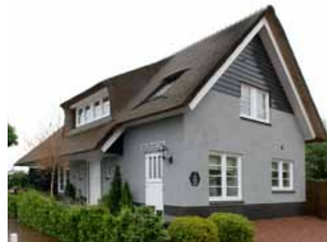
Fotografie: Bouwbedrijf ter Reehorst
