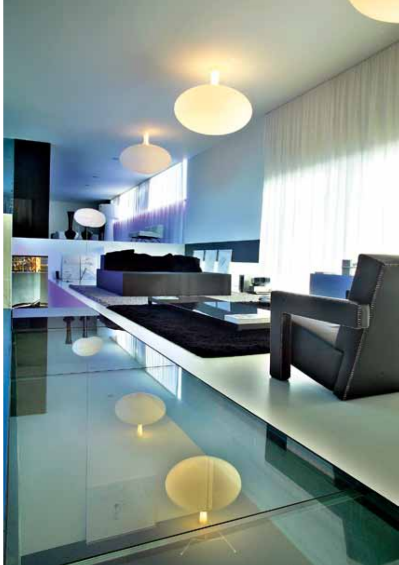
Transparante glazen vloerdelen tussen woongedeelte en werkruimte die een verdieping lager ligt
