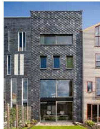
Woonhuis annex kantoor, Steigereiland
