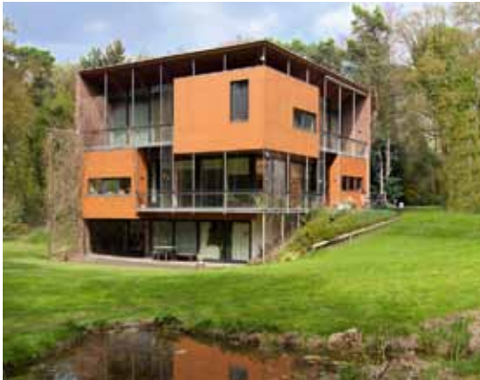
Energiezuinige woning - Wageningen
