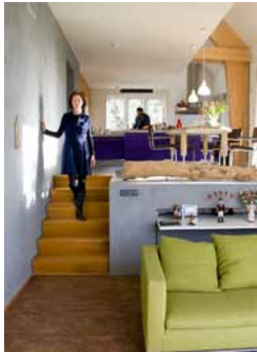
Warmtewanden met leemstuc
