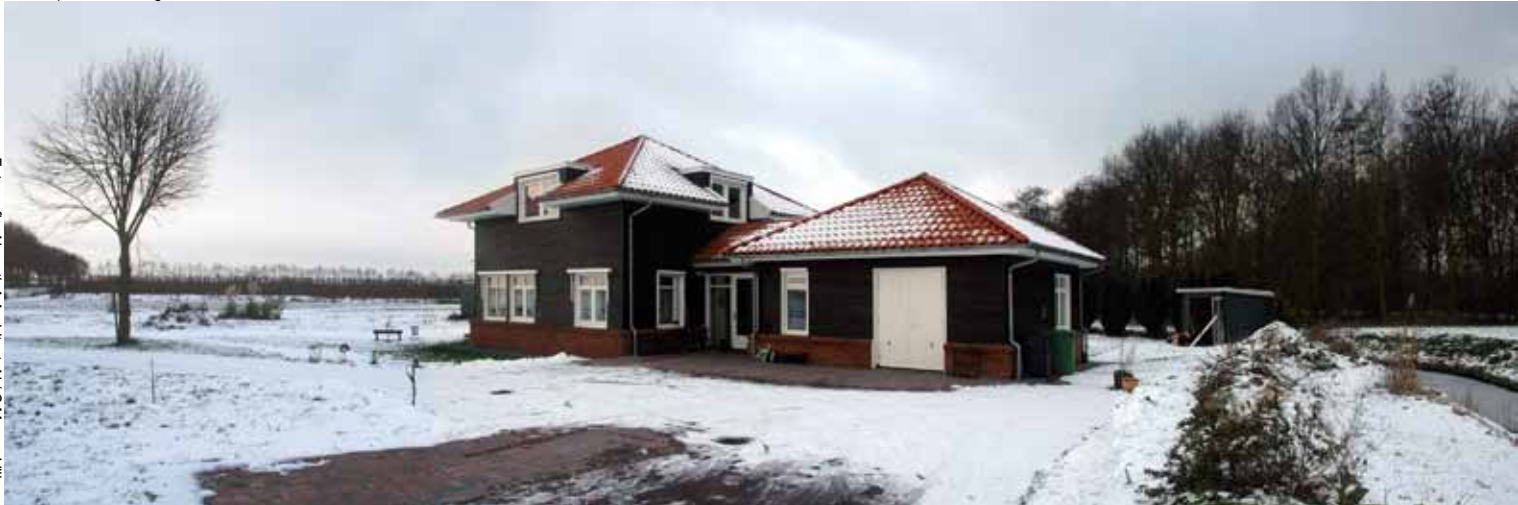
Houtskeletbouw (ecologische) woning met metselwerk - Vierpolders
