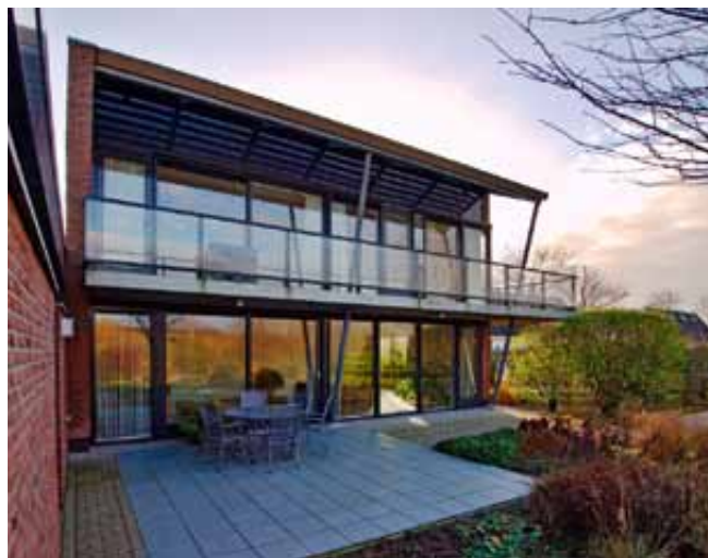
Woning Wijkweg - Langbroek
