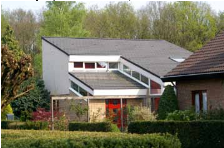
Woningverbouwing / reconstructie - Waalwijk
