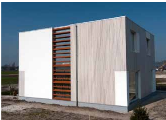
Montagewoning - De Contreie, Oosterhout
