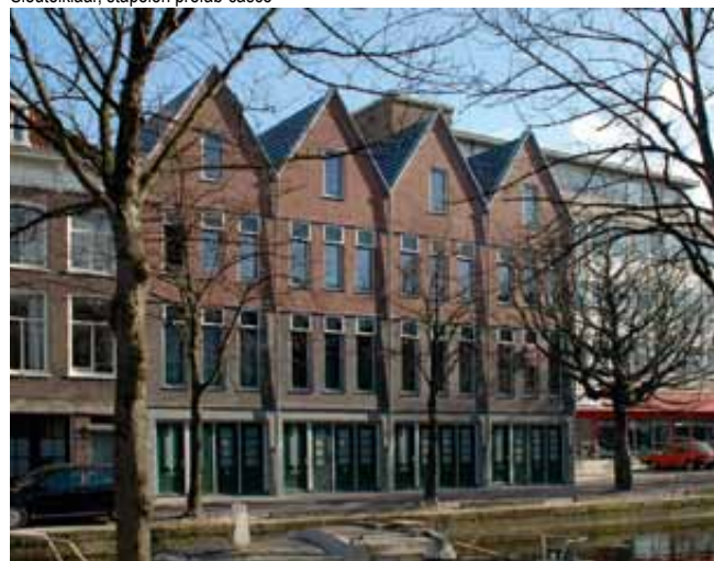
Gevels - Boomsluiterskade, Den Haag
