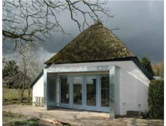
Verbouwing boerderij, interieur en exterieur
