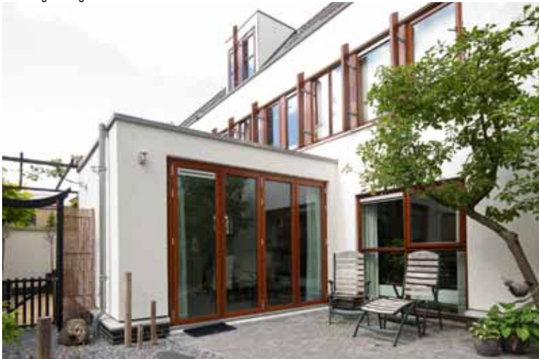
Bouwbegeleiding zij-uitbouw woonhuis - Amersfoort
