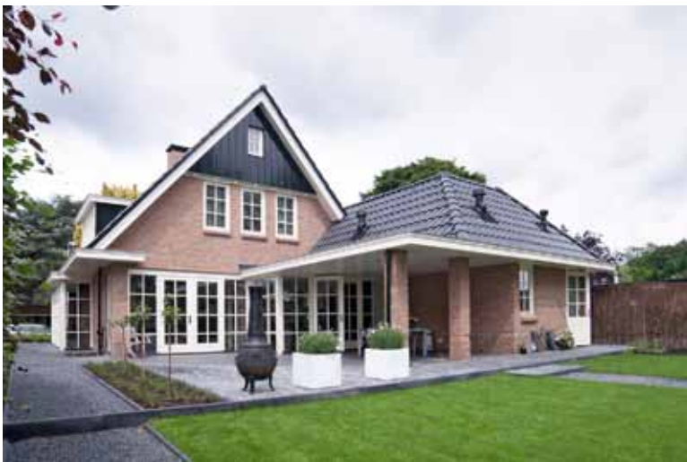
Bouwbegeleiding nieuwbouw woonhuis - Soest
