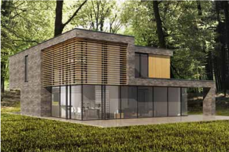
Villa Kerkebosch achtergevel - Zeist
