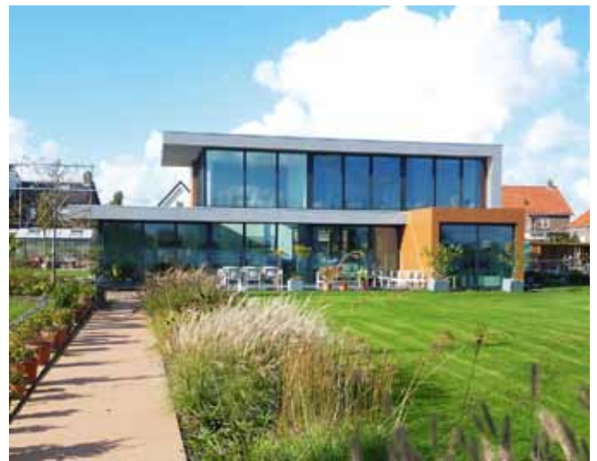
Woonhuis gevel waterzijde - Ter Aar
