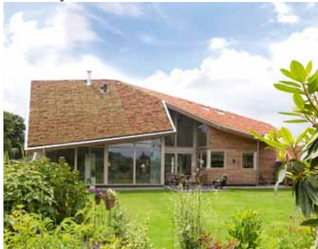
Duurzame woning - Den-Ham
