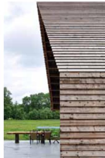
Verspringende daklijnen - Eemnes
