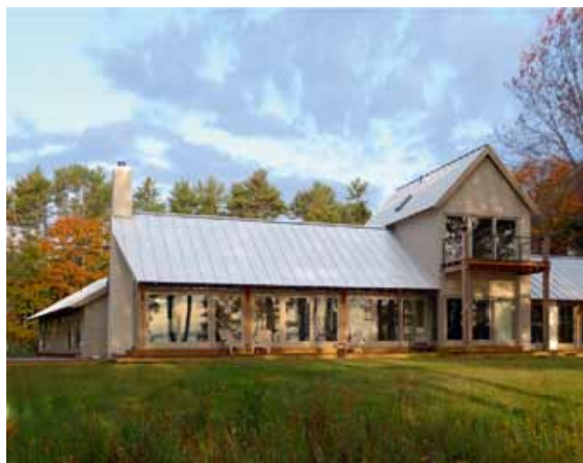
Woonhuis oceaanzijde - Portland Maine USA
