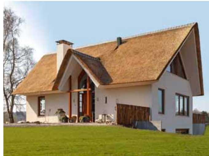
Bouwbegeleiding nieuwbouw duurzaam woonhuis - Beekbergen
