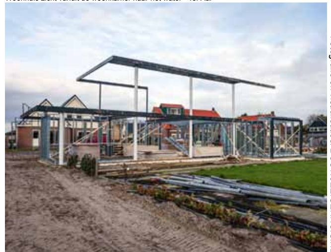
Woonhuis gevel waterzijde van de woning in aanbouw - Ter Aar
