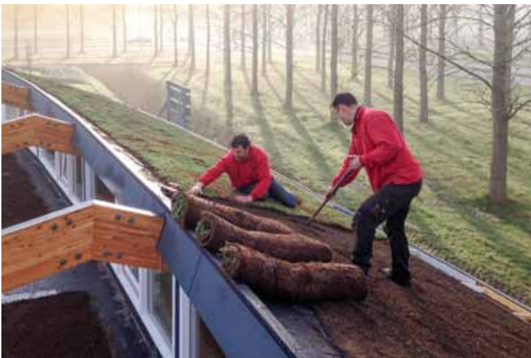
Aanleg groendak - Middenmeer
