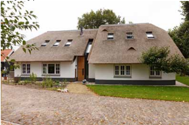
Bouwbegeleiding renovatie monumentale woonboerderij - Hoogland
