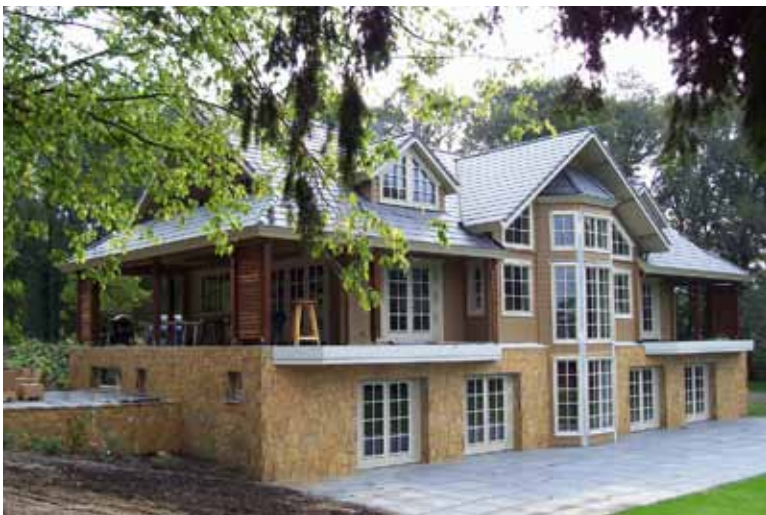
Villa op kelder - Oosterbeek
