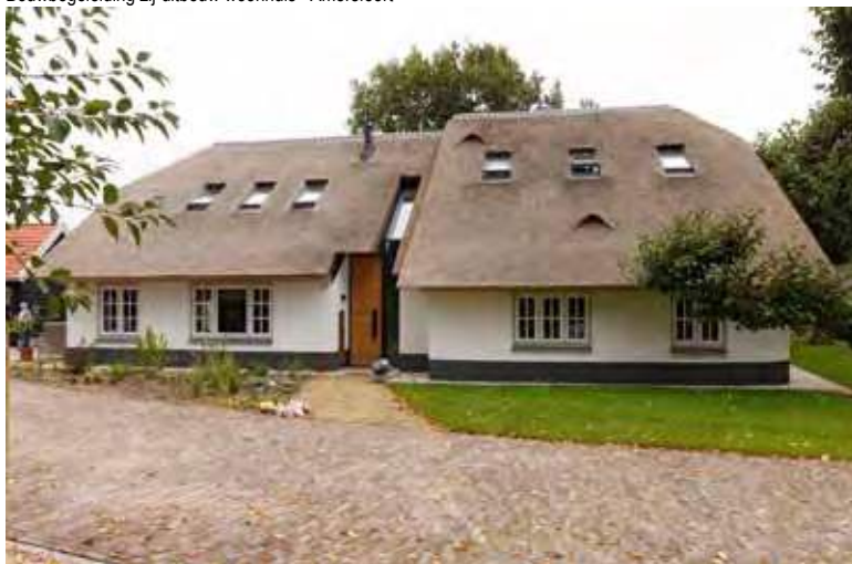
Bouwbegeleiding renovatie monumentale woonboerderij - Hoogland
