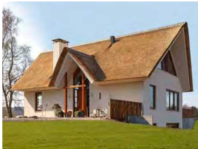
Bouwbegeleiding nieuwbouw duurzaam woonhuis - Beekbergen
