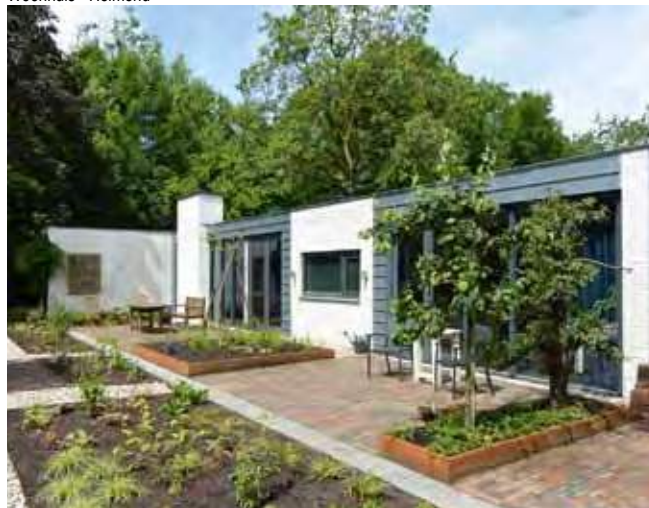
Energieneutraal woonhuis - Rosmalen
