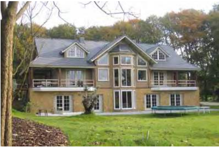
Villa op kelder - Oosterbeek
