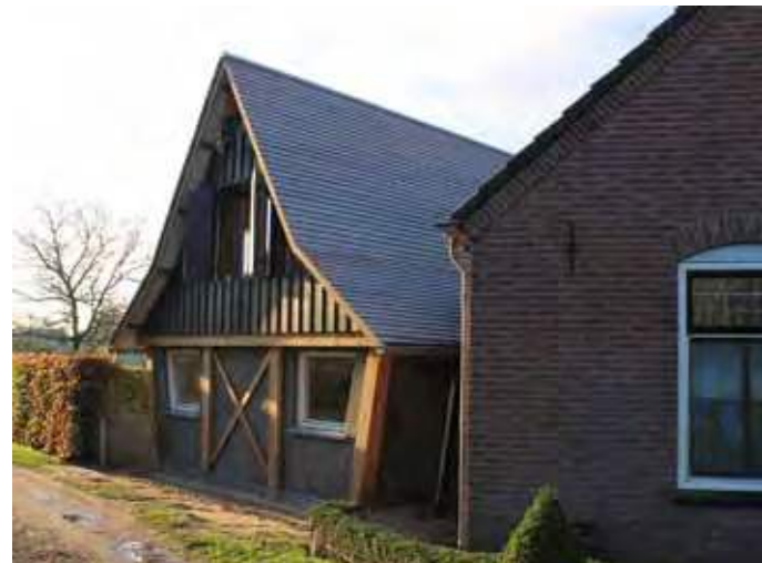
Hilde Huisje, houten dampopen dak & moderne vakwerktechniek - Wielpad
