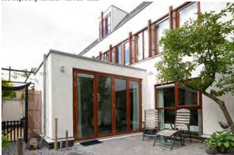
Bouwbegeleiding zij-uitbouw woonhuis - Amersfoort
