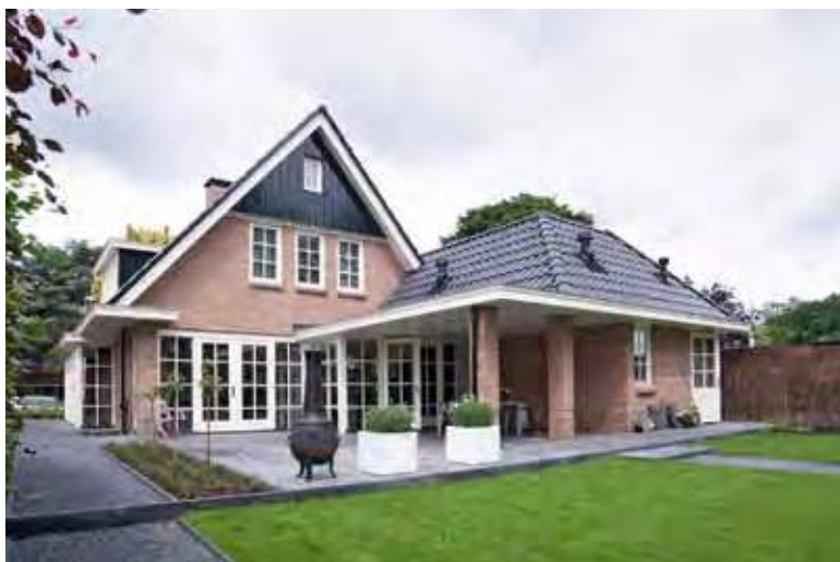
Bouwbegeleiding nieuwbouw woonhuis - Soest
