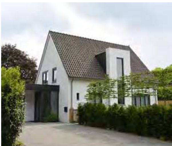
Energiezuinig woonhuis - Rosmalen
