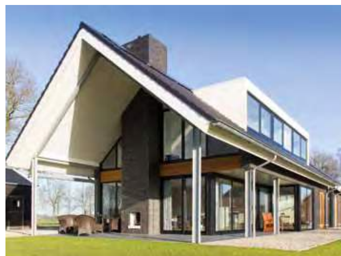
Schuurwoning - Laren (gld)
