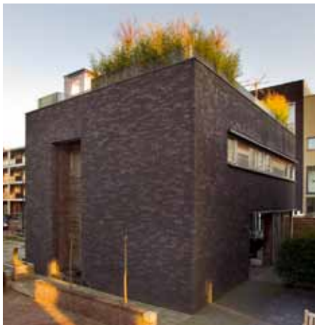
Stadsvilla op Steigereiland - IJburg Amsterdam
