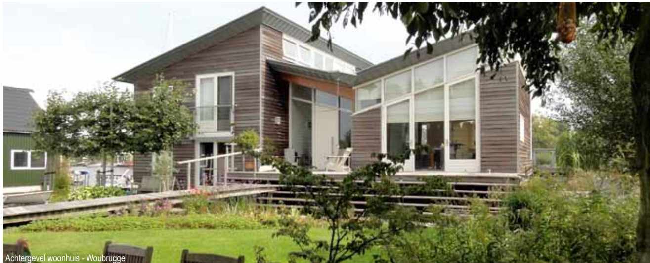
Achtergevel woonhuis - Woubrugge
