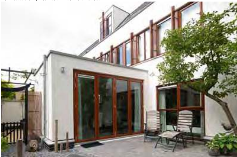
Bouwbegeleiding zijuitbouw woonhuis - Amersfoort
