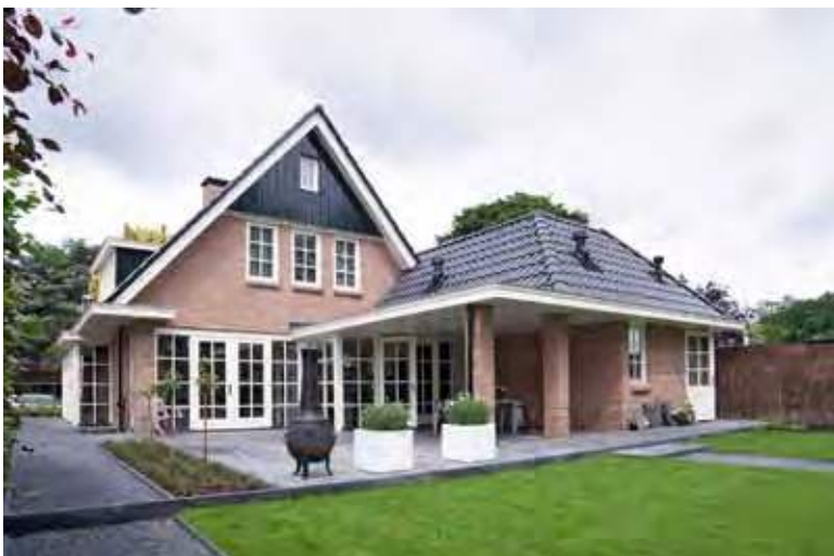
Bouwbegeleiding nieuwbouw woonhuis - Soest
