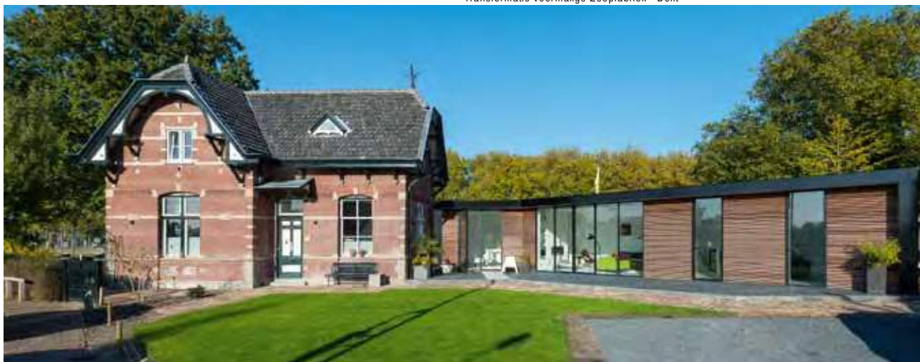
Renovatie en uitbreiding voormalige brugwachterswoning - Delft
