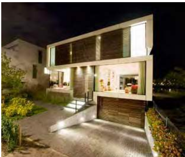
Villa S2 - Rieteiland Oost, IJburg, Amsterdam
