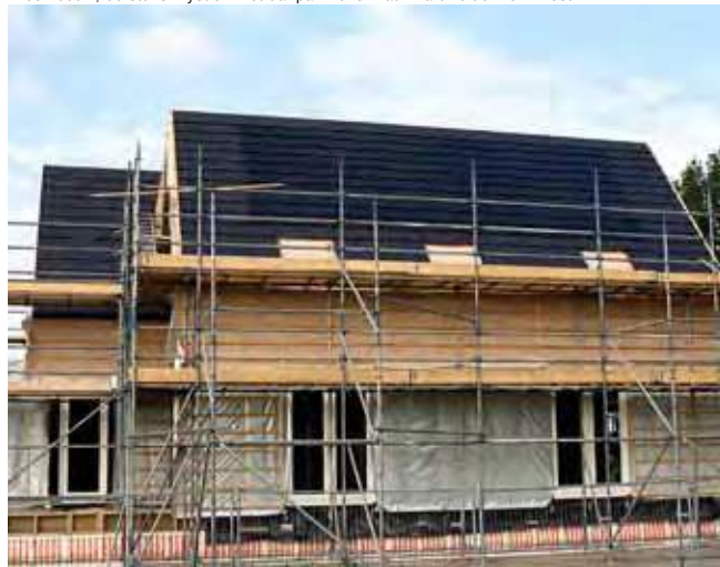
Nieuwbouw, 60 stuks Mystiek met dakpan Tuile Plat zwart-voldonker - Hoofddorp
