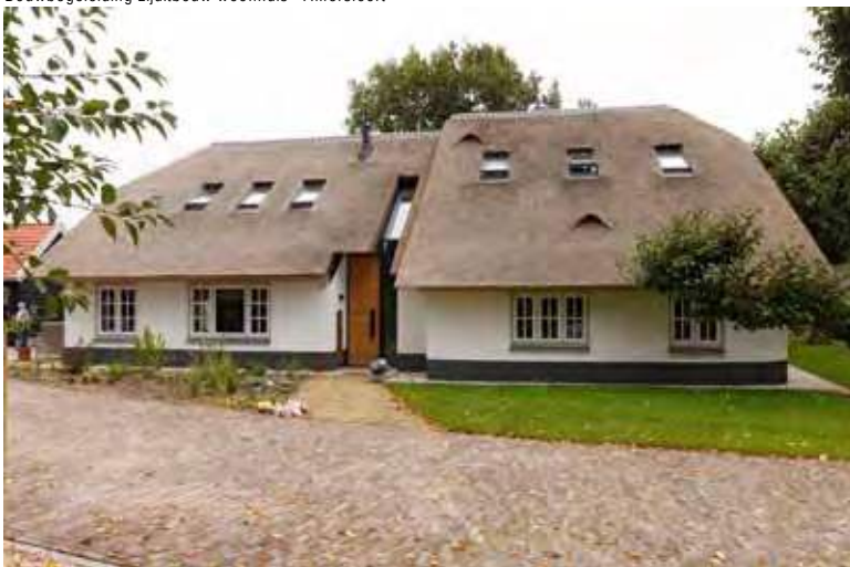
Bouwbegeleiding renovatie monumentale woonboerderij - Hoogland
