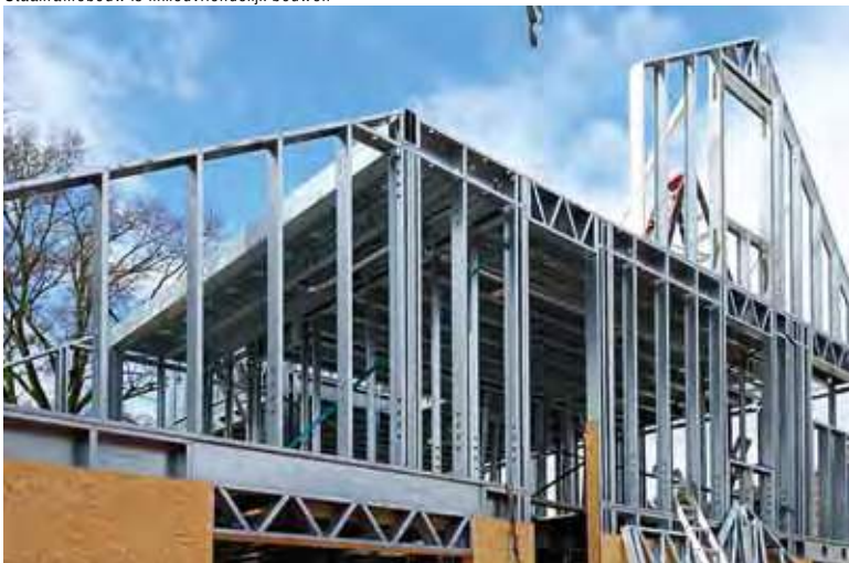
Staalframebouw: een snelle bouwtijd met lage energiekosten
