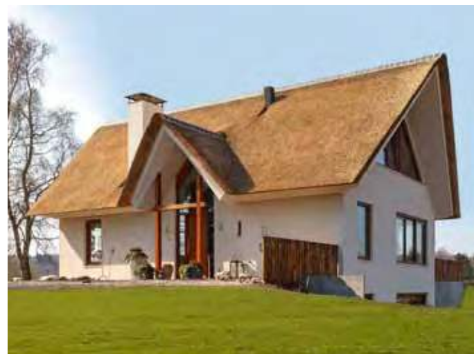
Bouwbegeleiding nieuwbouw duurzaam woonhuis - Beekbergen
