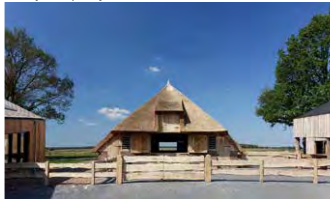
Restauratie en nieuwbouw schaapskooi - Ruinen
