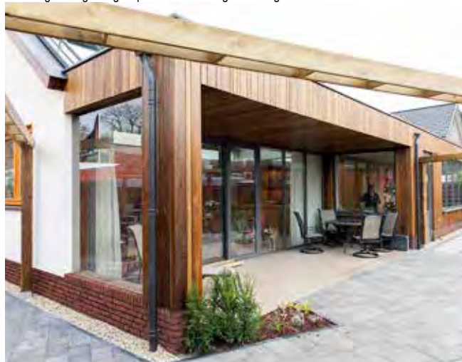
Detail bouwbegeleiding energie opleverende woning - Driebergen
