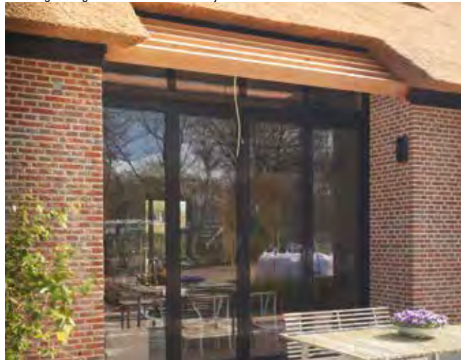
Detail bouwbegeleiding nieuwbouw woonboerderij - Blaricum
