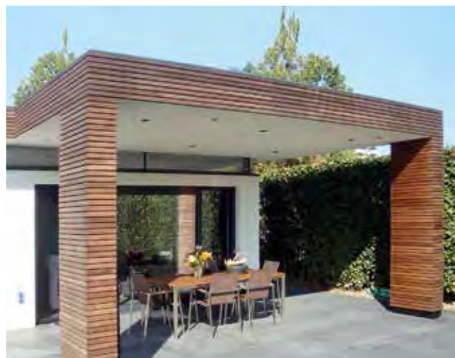
Aanbouw, terrasoverkapping - Venlo
