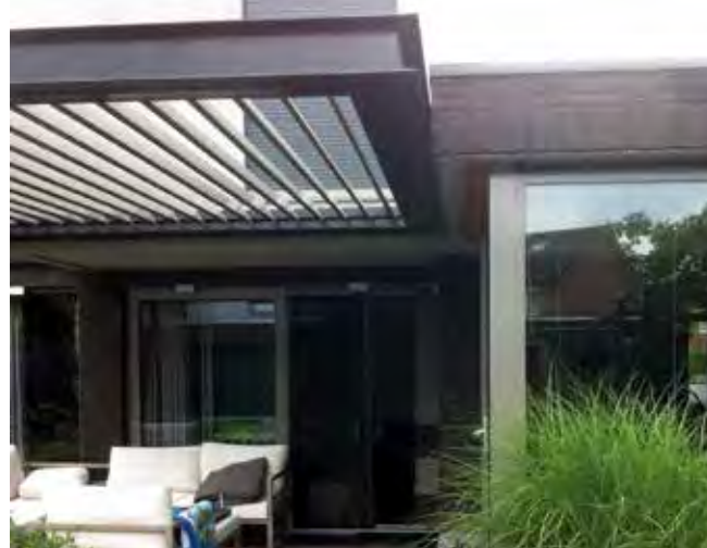
Aanbouw, louvredak - Berings
