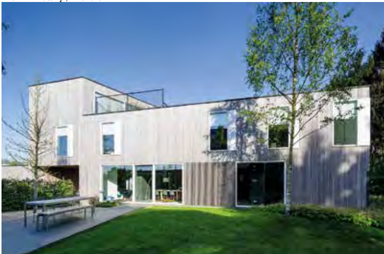
Villa Waterland - Eindhoven
