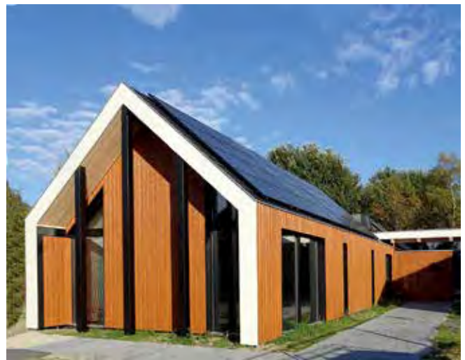
P & B moderne schuurwoning - Herpen
