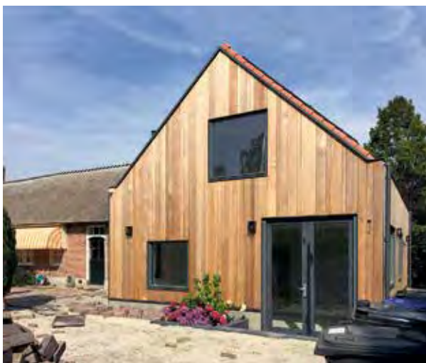
Wevershuisje, nieuw gebouwd gastenverblijf - Laren
