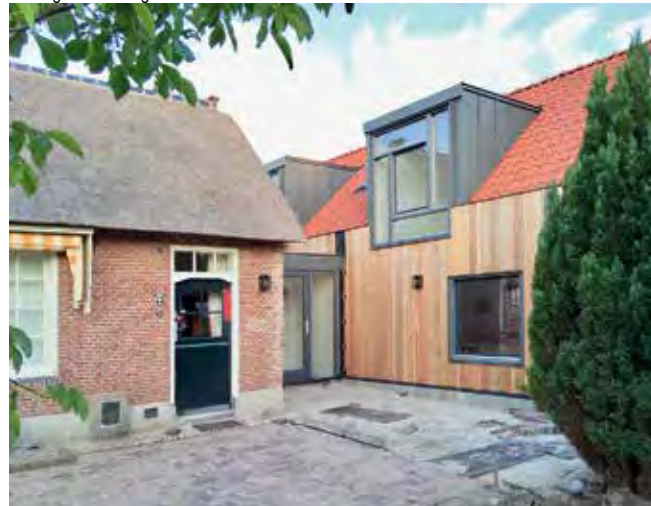
Wevershuisje, nieuw gebouwd gastenverblijf - Laren
