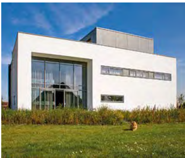
Woning Watermunt exterieur - Othene, Terneuzen
