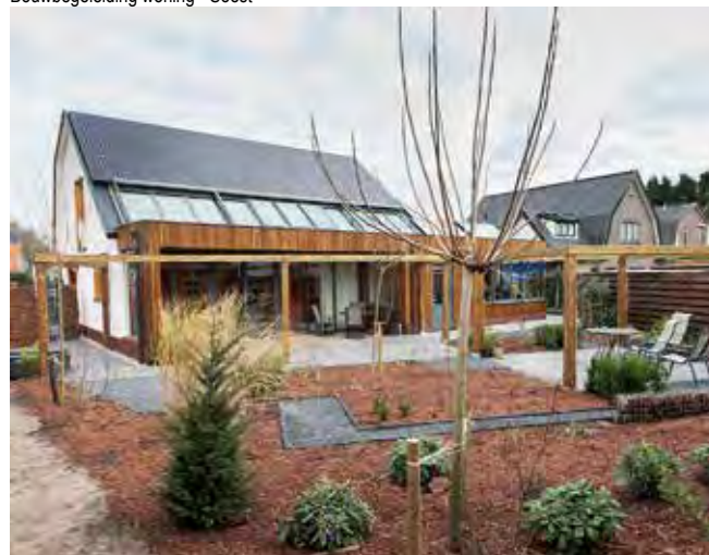
Bouwbegeleiding energie opleverende woning - Driebergen
