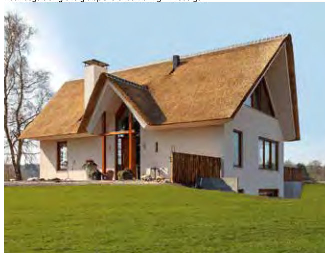
Bouwbegeleiding energieneutrale woning - Beekbergen
