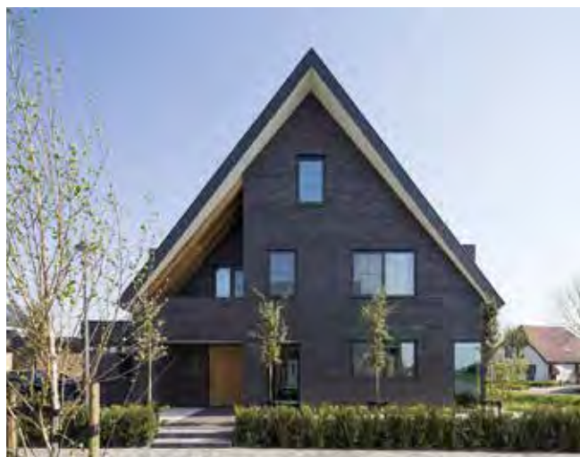
Fotografie: Brouwer bureau Bouwkunde
