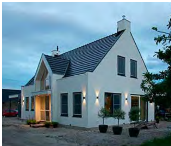
Woning in staalframe - 's Gravenmoer
