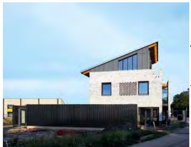
Huis W1 in bouw - Domburg
