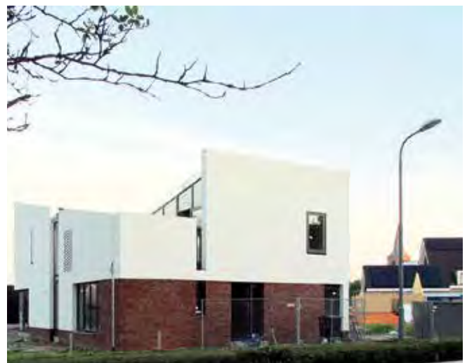
Huis W2 in bouw - Domburg
